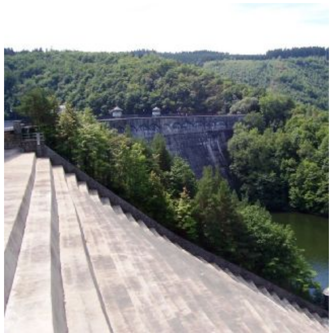
Imposant: Staumauer und Kaskadentreppe der Urftseestaumauer
